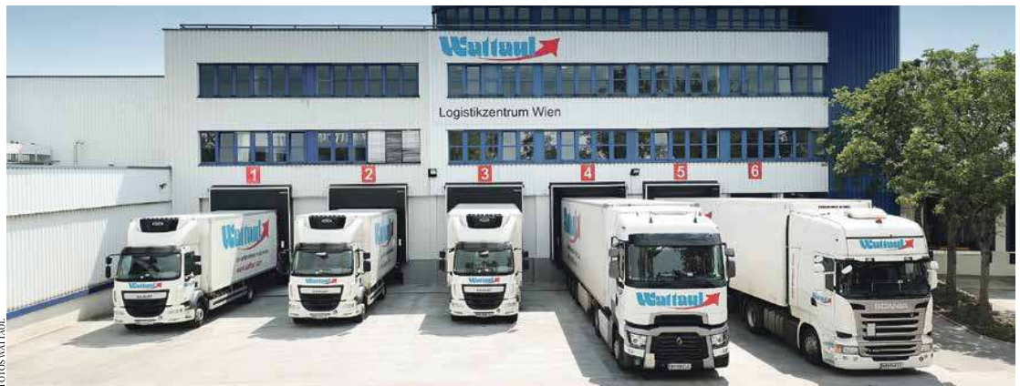
Standort Wien: für die Lebensmittellogistik und Feinverteilung an Großküchen, Schulen, Kindergärten und Pensionistenheime
